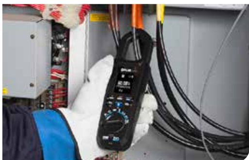
Controleren van stroommetingen
