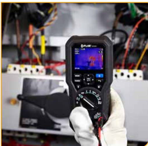
Warmtebeeldscan van elektrisch systeem
